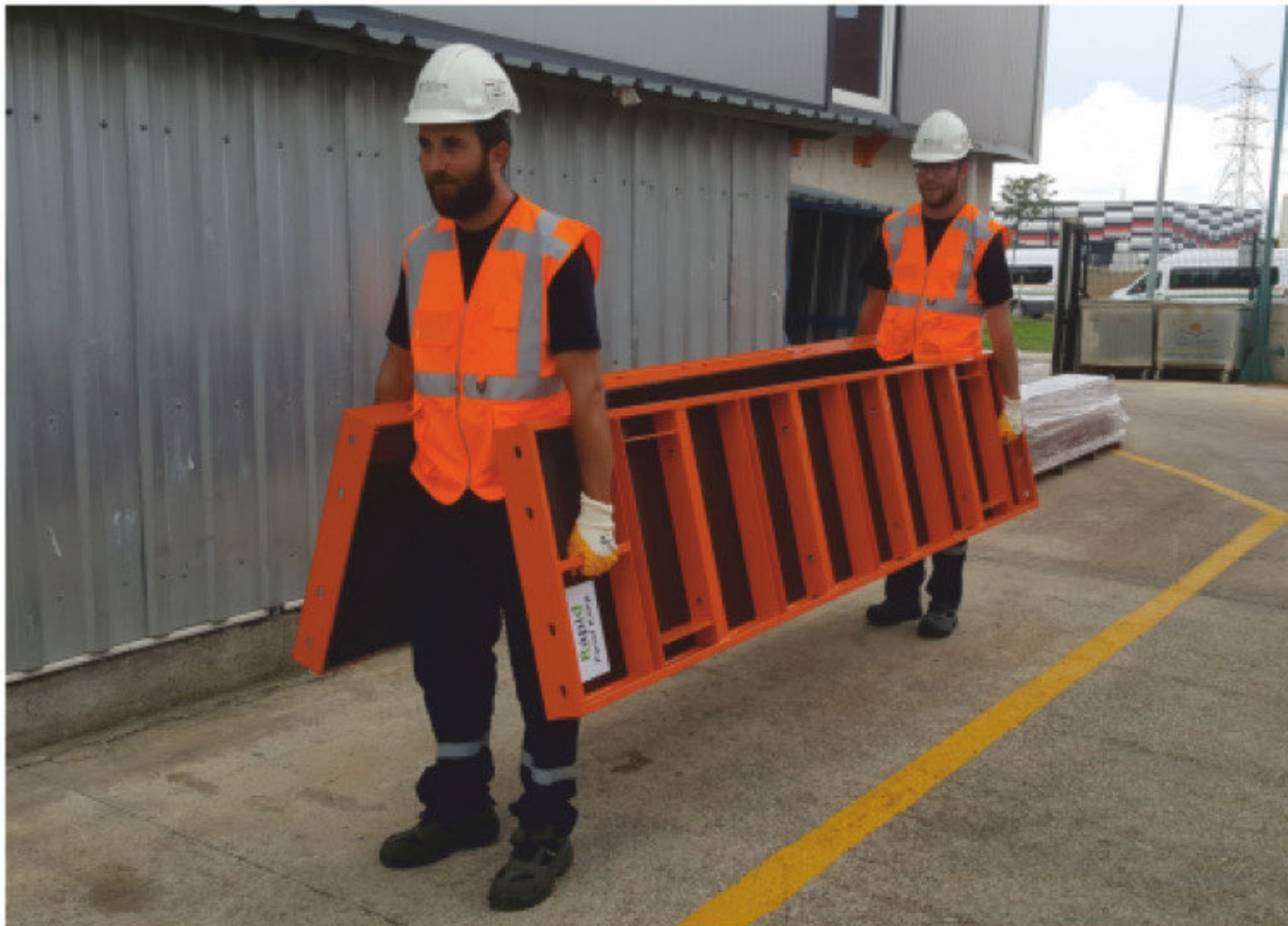
Rapid paneller hem yatay hem de düşey olarak kullanılabilir. / Rapid panels can be used both horizontally and vertically.
